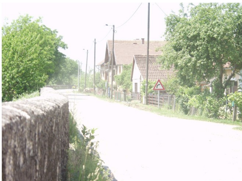
Slika 31. Lokacija predmetnog obrambenog nasipa – zida u odnosu na stambene objekte u naselju Tanac (izvor: PPU Općine Tanac)
