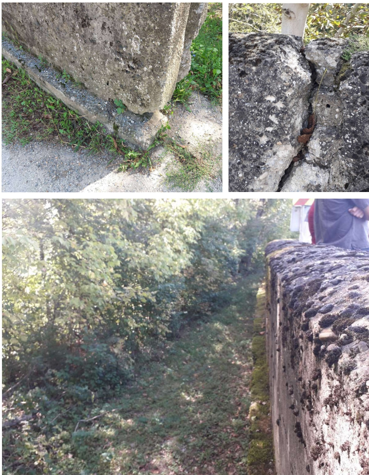
Slika 2. Prikaz postojećeg stanja predmetnog zida
