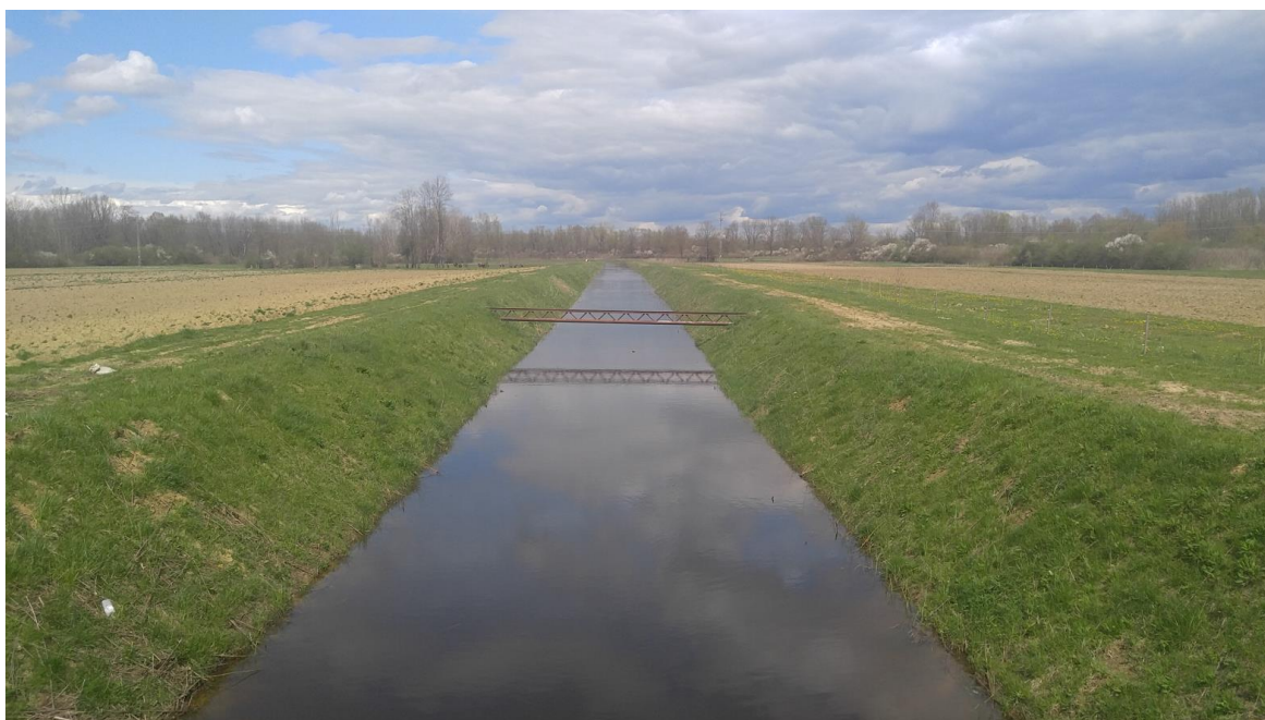
Slika 2.1-2. Postojeće stanje na lokaciji – odvodni kanal Logomerčica
