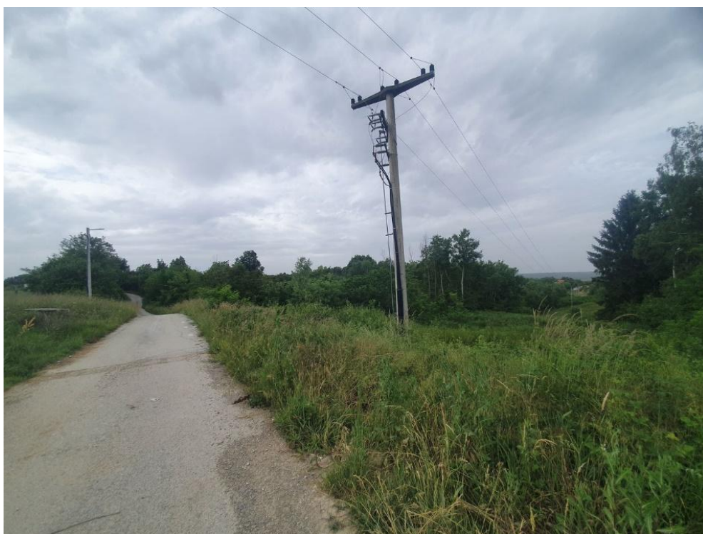
Fotografija C-18: Pogled na dio trase kod stacionaže 1+850 m (desno dolje)
