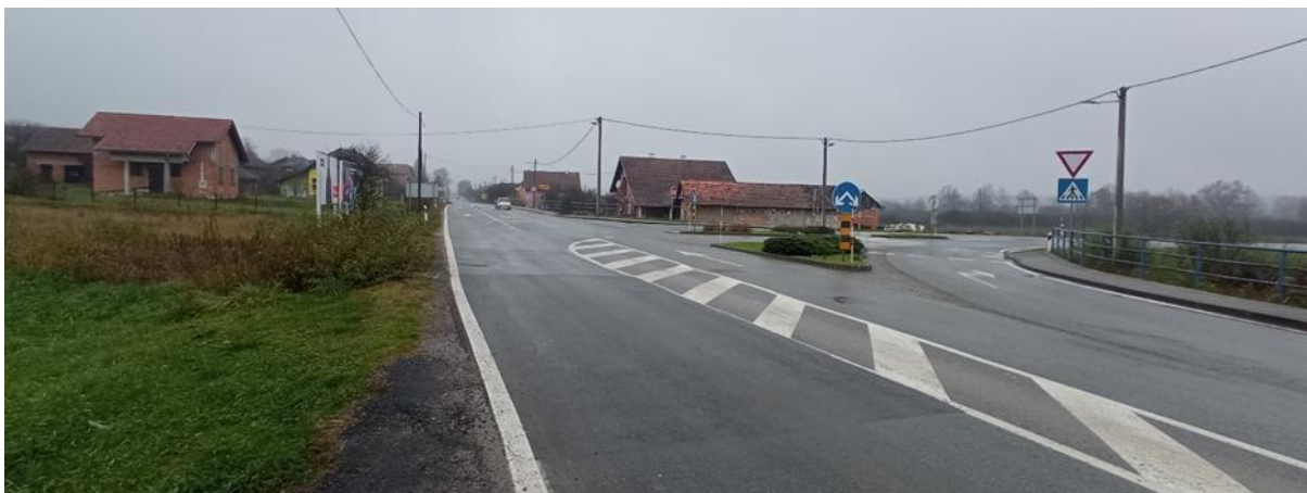
Fotografija A-1: Raskrižje 1-početak zahvata (0+000 km)
