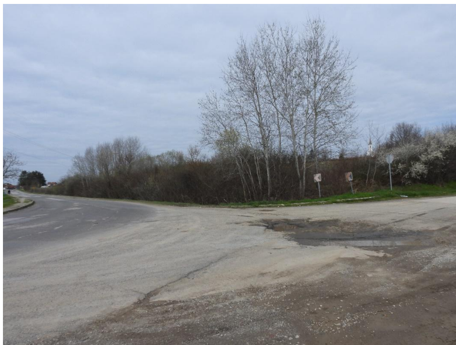
Fotografija C-43: Točka 10: Antropogeno stanište (postojeća prometnica) na kraju trase planirane prometnice, oko stacionaže 6+800
