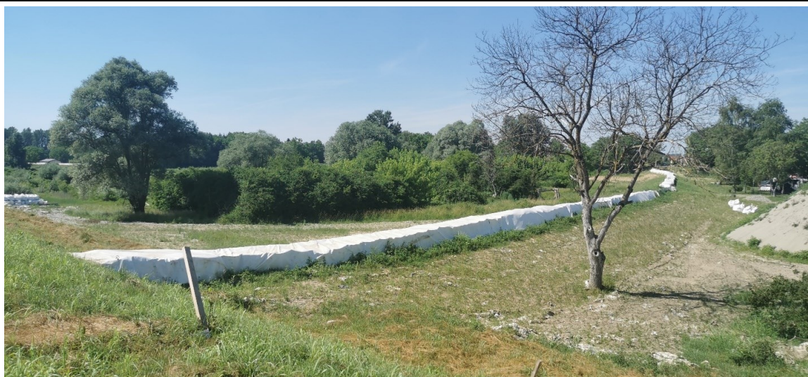
Izvedena privremena 2. linija obrene od poplave od box barijera
