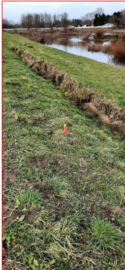
Vodna i zaobalna strana nasipa : pukotine u pokosu nasipa širine 30 cm te na spoju berme i tijela nasipa.
