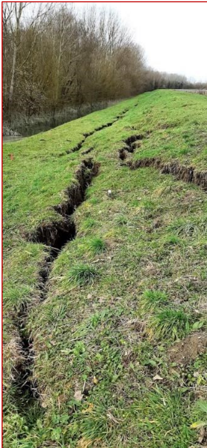
Vodna i zaobalna strana nasipa : pukotine u pokosu nasipa širine 30 cm te na spoju berme i tijela nasipa.
