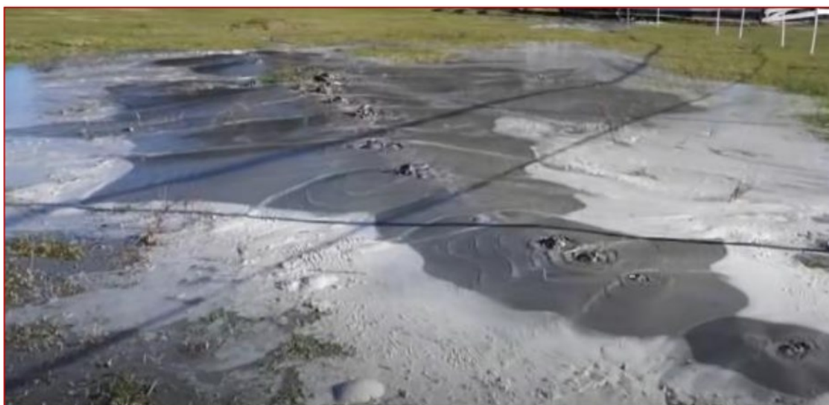
Izbacivanje pijeska kroz pukotinu u zaobalju oko 100 m od nasipa (izvor: Udruga Kas, Danijel Pavlič 2020.)
