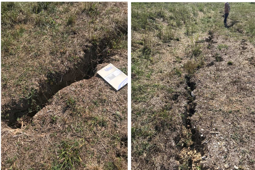
Fotografija 2.3-5 Skup pukotina 3
