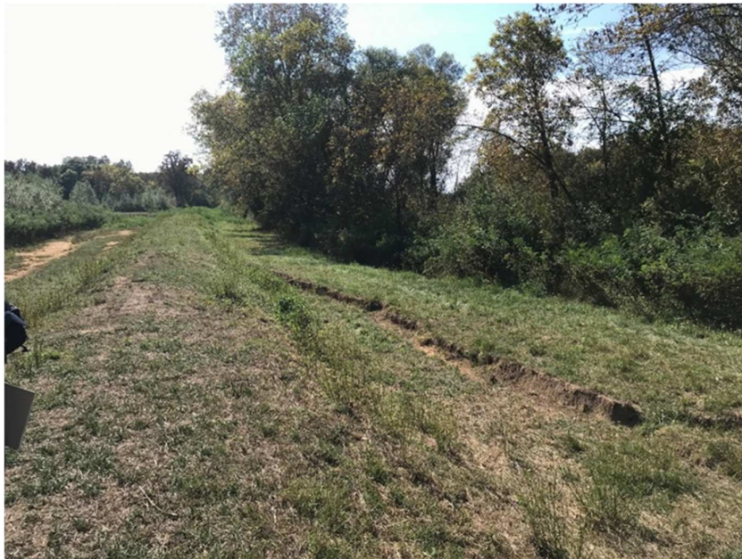
Fotografija 2.3-1 Nasip od stacionaže 0+000 do 0+234
