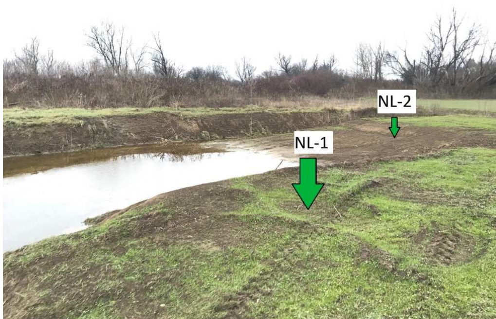
Fotografija 2.5-1 Lokacije plitkih raskopa
