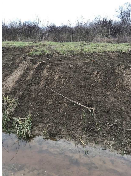
Fotografija 2.5-5 Pokos postojećeg iskopa materijala
