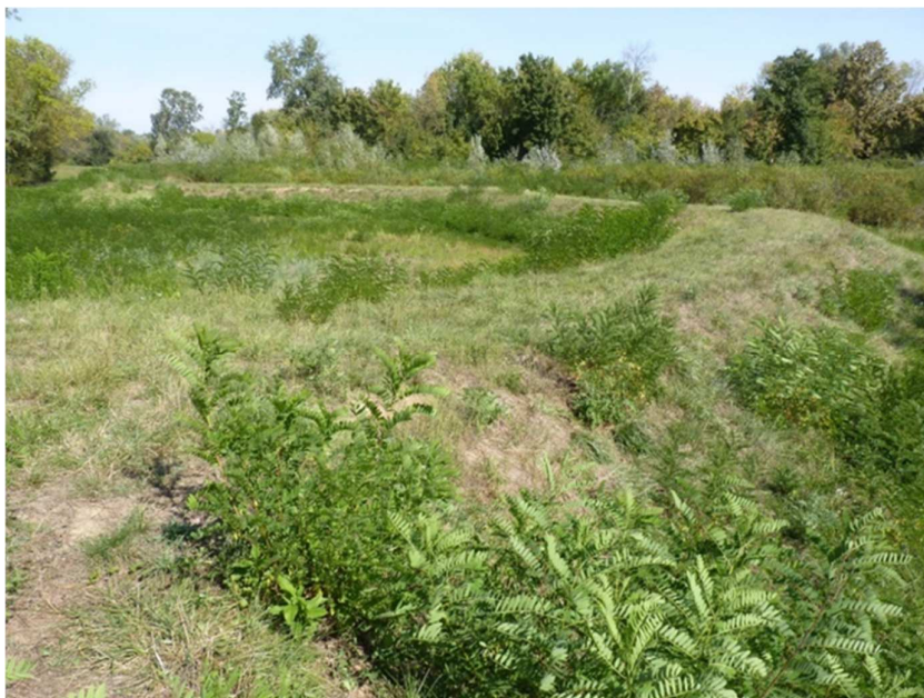
Fotografija 2.3-2 Nasip od stacionaže 0+234 do 0+298
