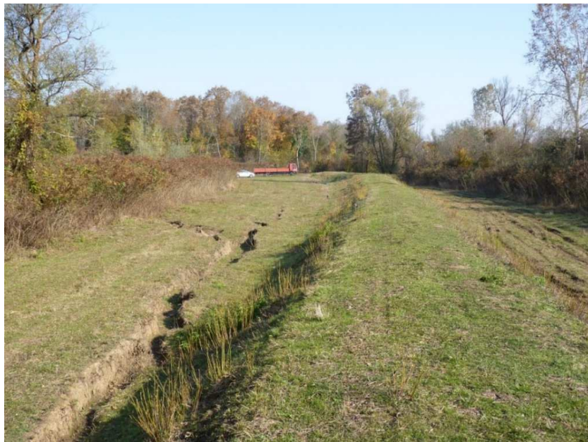
Fotografija 2.3-14 Nasip na stacionaži 0+021 – 0+138
