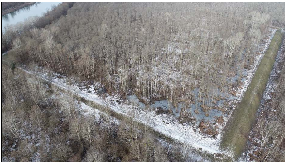
Slika 5. Postojeće stanje južnog nasipa retencije Mlaka, slika 1 (Glavni projekt, Geokon-Zagreb d.d., svibanj 2021.)
