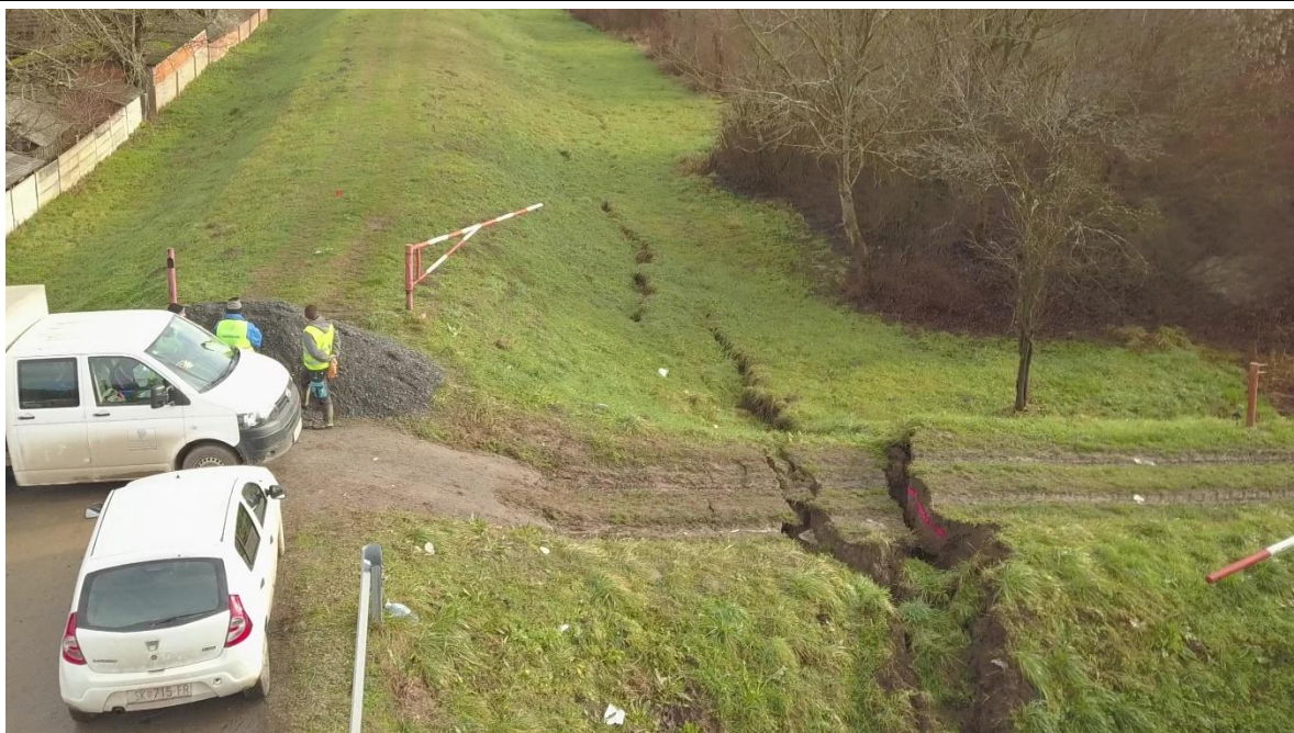
Pripreme za sanaciju rampe u inundaciju
