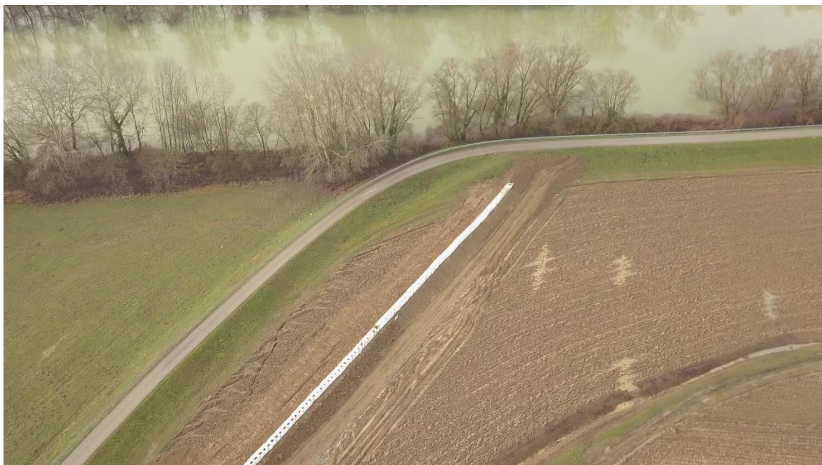
Izvedba box barijera u zaobalju
