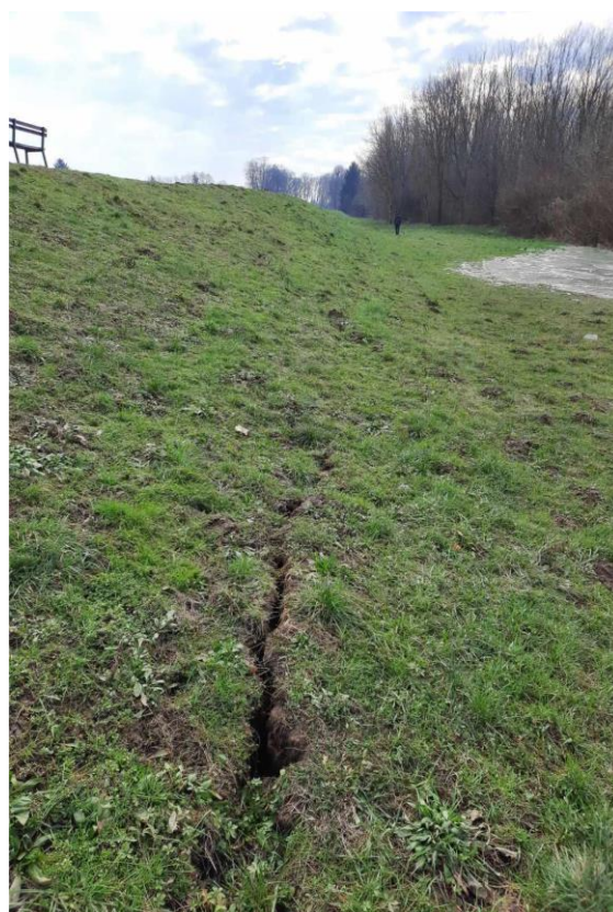
Uzdužna pukotina na pokosu i u nožici nasipa
