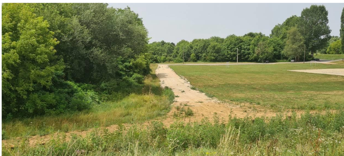
Pogled na zaobalnu stranu zone sanacije nasipa, privremena pristupna cesta
