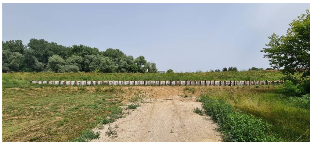
Privremena sanacija nasipa u duljini od oko 50 m - box barijere i drveni piloti, privremena pristupna cesta
