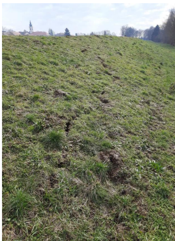
Uzdužna pukotina na pokosu i u nožici nasipa
