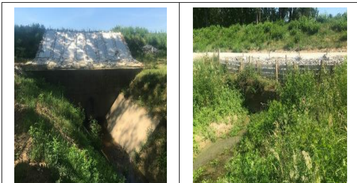
Slika 6. Privremena sanacija oštećenja čepa (nizvodno-uzvodno) - Dionica 4
