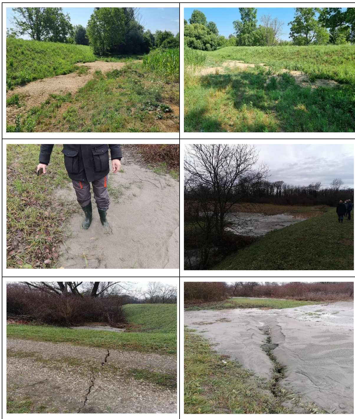
Slika 2. Oštećenja nasipa u vidu pukotina duž nasipa te količina izbačenog pješčanog materijala na površini pukotina i okolnog tla na predmetnoj dionici nasipa
