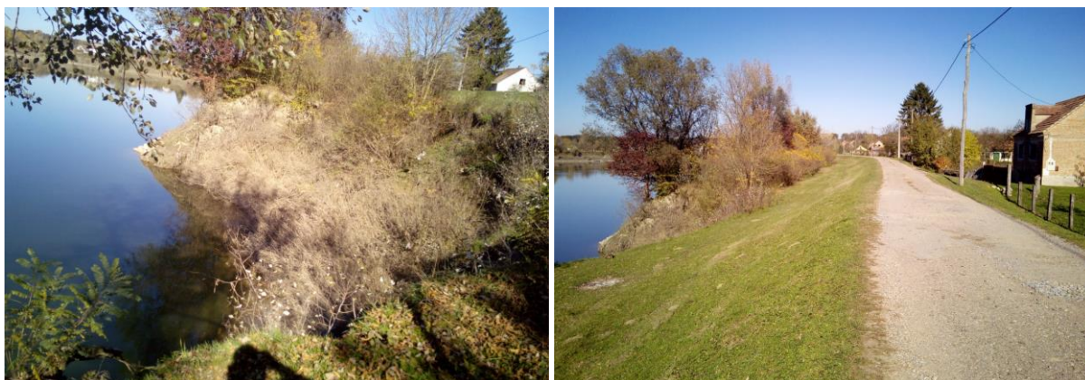
Fotografija 2-3: Nestabilnosti obale uz postojeći obrambeni nasip (a-b)
