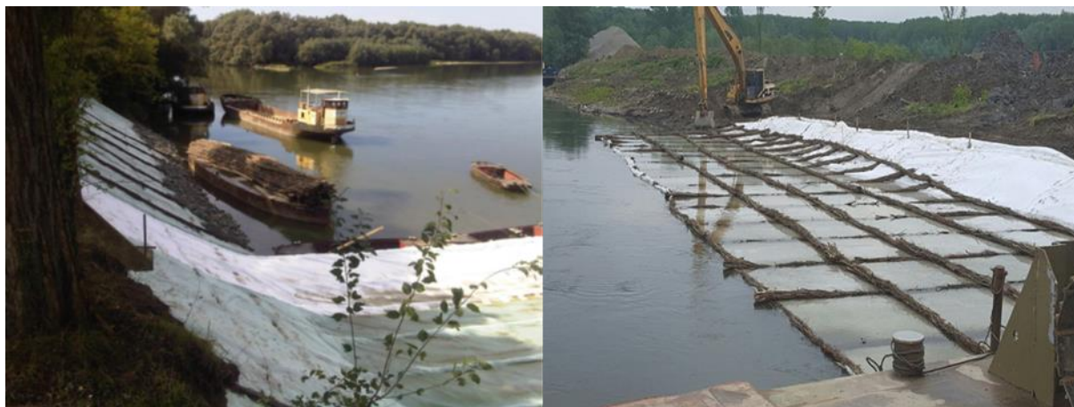
Fotografija 2-4: Izgradnja obaloutvrde s fašinskim madracem
