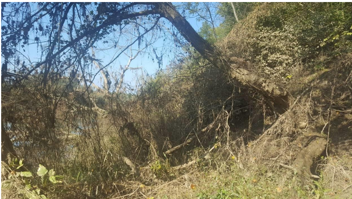
Fotografija 2-3: Pogled na odron s vodne strane
