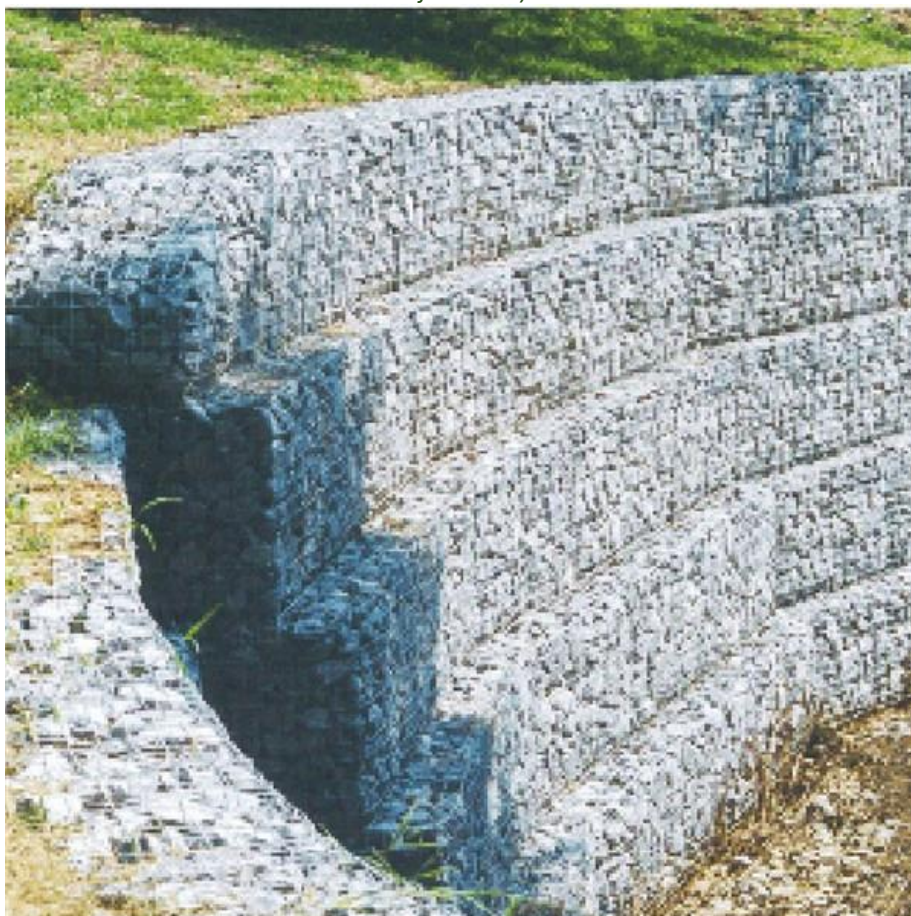
Grafički prikaz 2-4: Izgled vertikalne gabionske obaloutvrde
