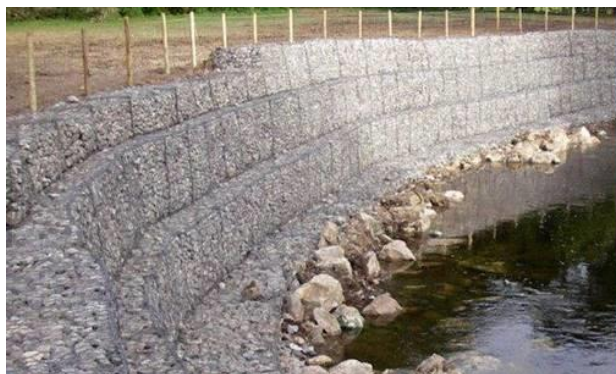
Grafički prikaz 2-7: Izgled gabionskog koša i izvedenog potpornog zida u koritu vodotoka
